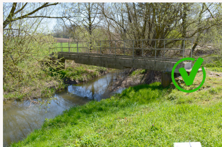
Posée sur les hauts de berges, la passerelle ne déstabilise pas les rives et autorise leur entretien.
