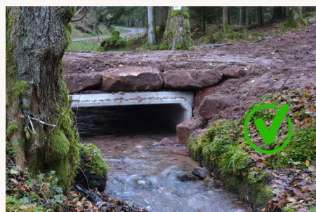
Continuité écologique et circulation perenne des engins lourds et véhicules sont assurées par les ponts cadres.
