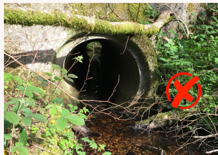
Source d'embâcles et frein à la vie aquatique, la buse est à proscrire.
