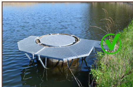
Le moine permet d'oxygéner les eaux fraîches de fond lors de vidange. L'impact (variation de températures, asphyxie...) sur le cours d'eau récepteur est alors limité.
