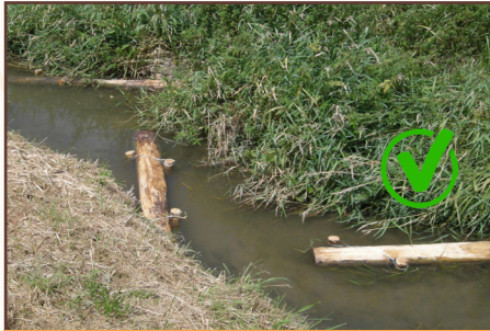
Les déflecteurs favorisent la dynamique fluviale qui limite l'apparition d'alluvions.
