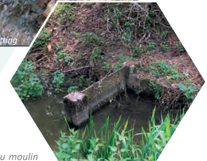
Seuil de décharge du moulin d'une ancienne usine, sur la Vezouze (Blâmont).
