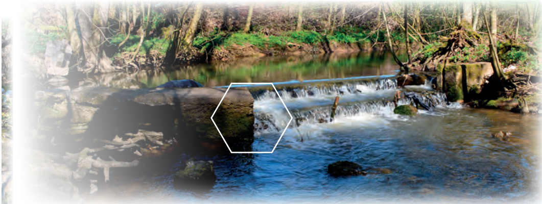
Seuil de prise d'eau de l'étang sous Launoy, installé sur la Blette à Sainte-Pôle.
