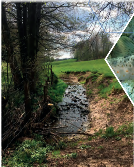
Érosion des berges sur l'Herbas. En l'absence de ripisylve, la berge subit un important affaissement.
